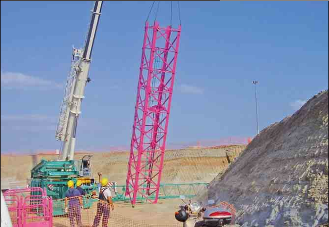
Prima fase di sollevamento: 2 - Elemento prossimo alla posizione verticale
