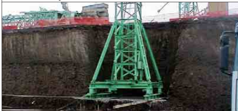
Gru ancorata a plinto di cemento armato - Carro di base senza zavorra
