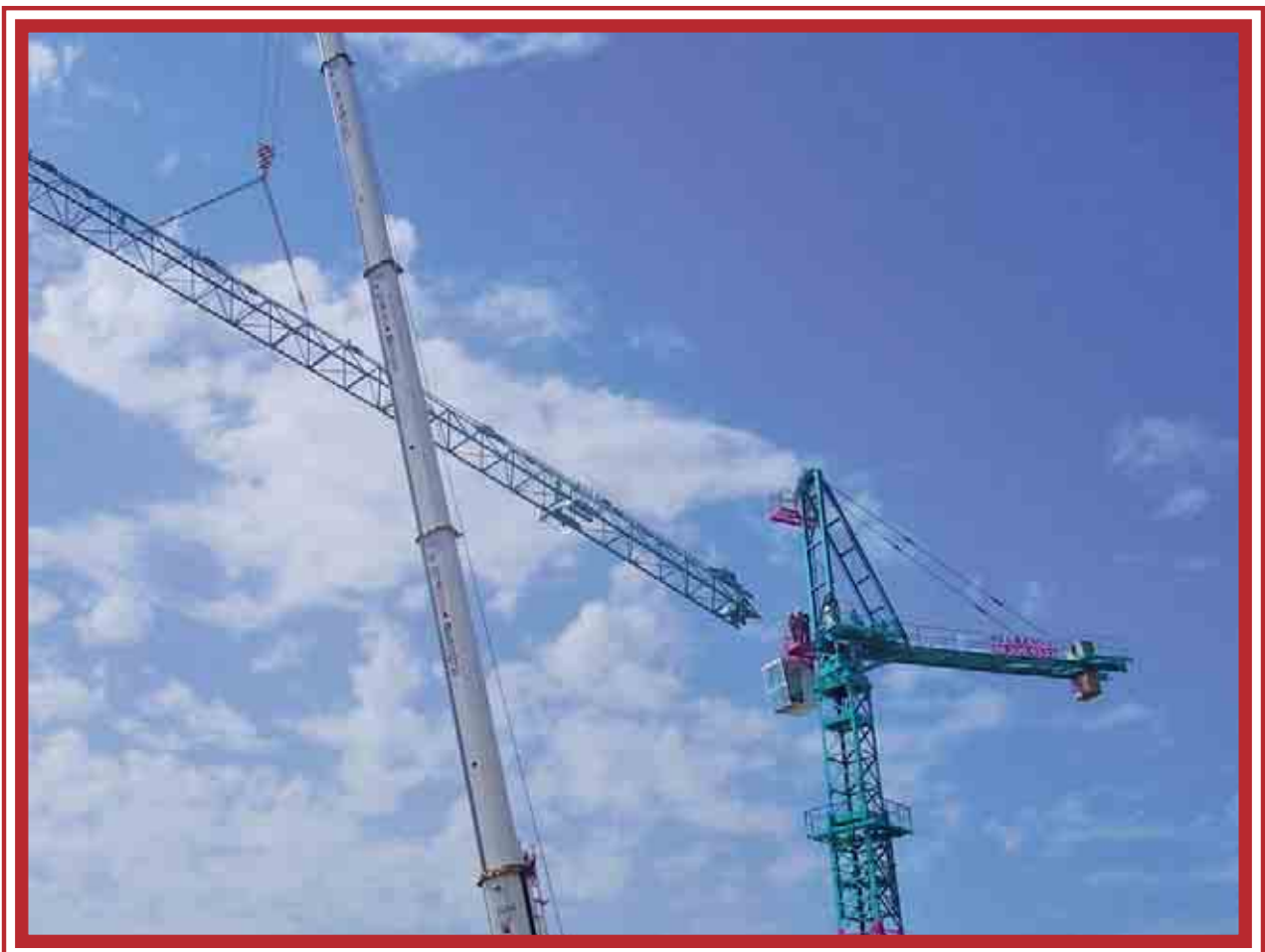
Lavoratori sulla cuspide della gru in attesa del ricevimento del braccio
