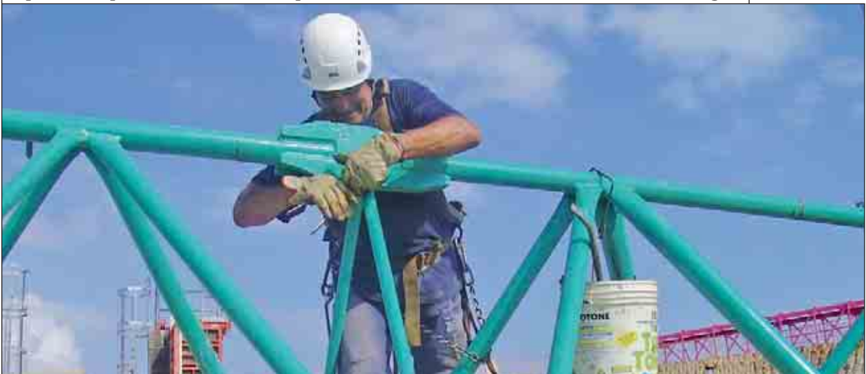
Operatore equilibrato da cintura di posizionamento che assembla a terra il braccio della gru
