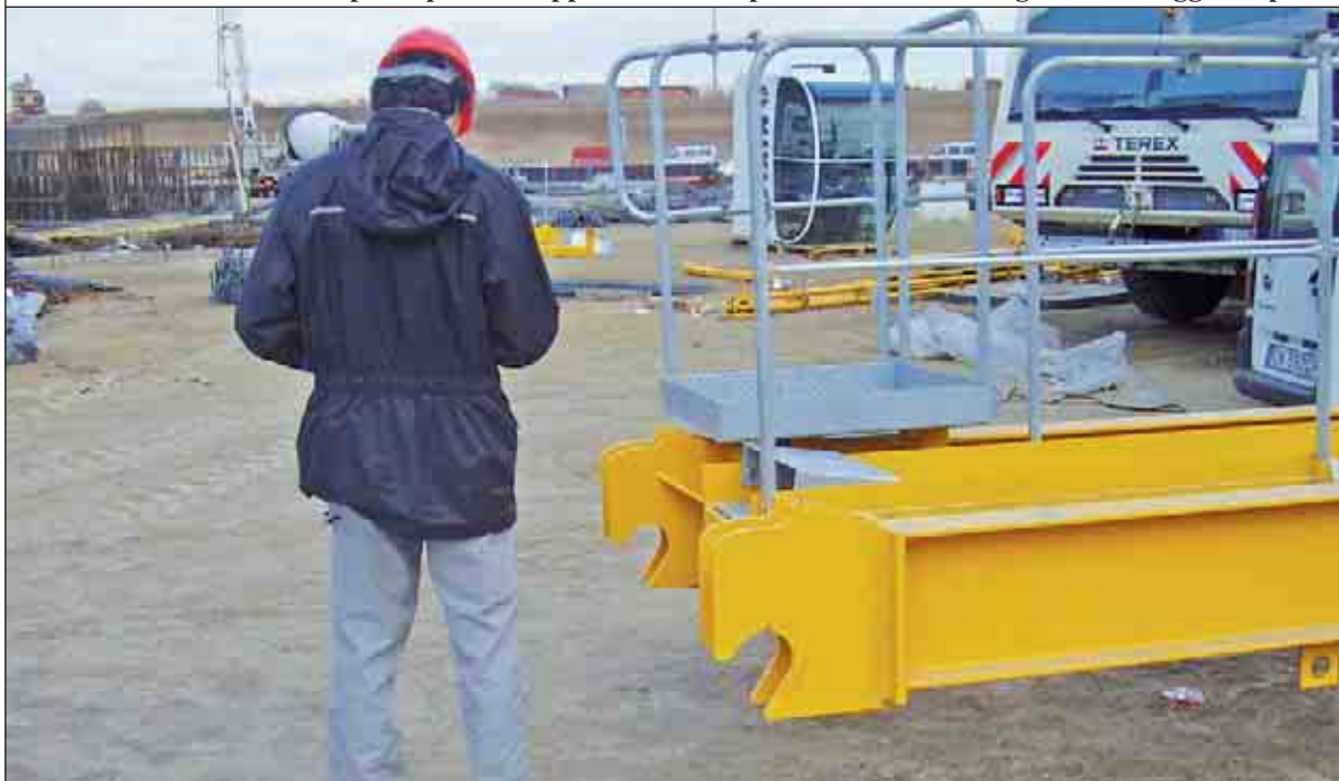
Controbraccio: cerniera aperta per l'accoppiamento alla parte della torre ove già sono alloggiati i perni
