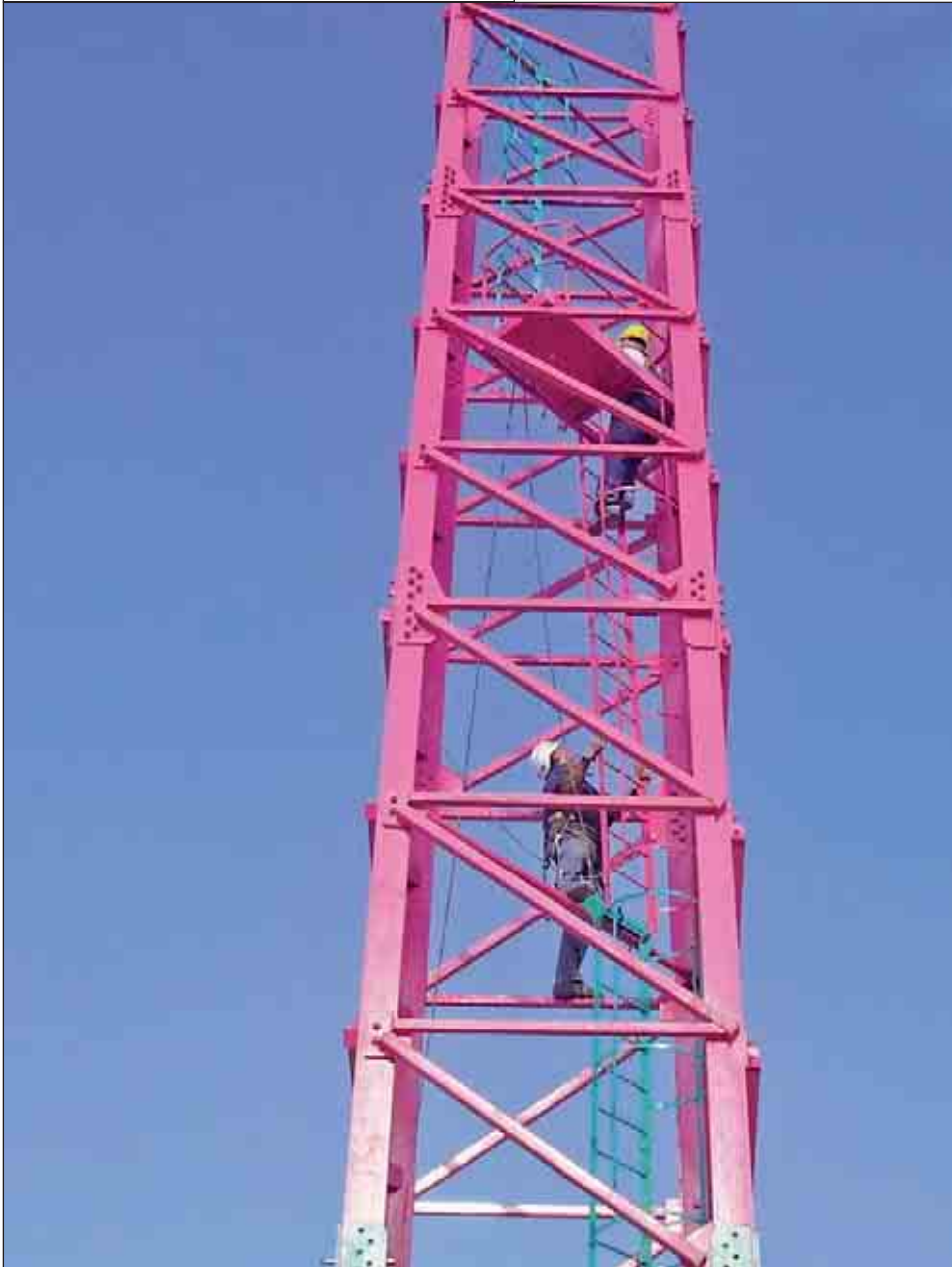
Risalita di un elemento dopo il montaggio
