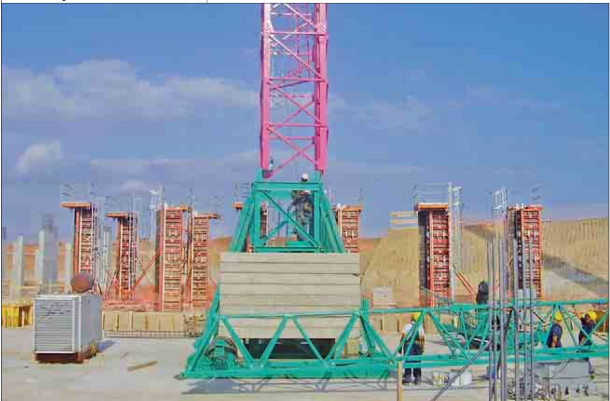
Preso del primo elemento di torre
