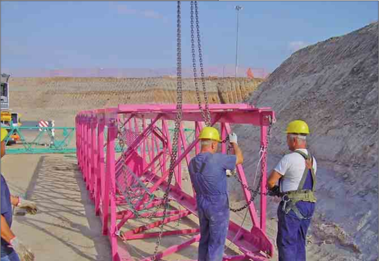
Preparazione del sistema di aggancio di un elemento della torre
