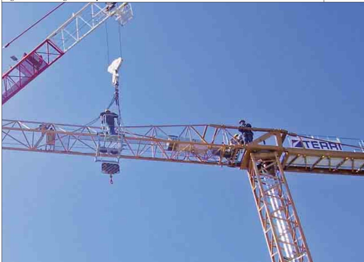
Sgancio delle braghe dall'operatore a bordo del ballatoio installato sul carrello di sollevamento
