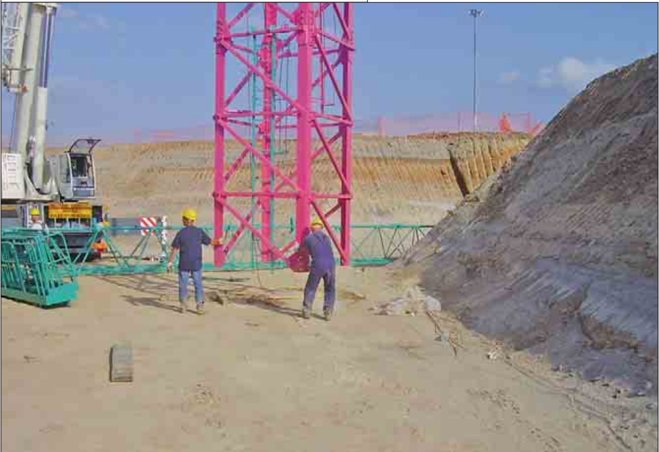
Prima fase di sollevamento: 3 - Stabilizzazione dell'elemento
