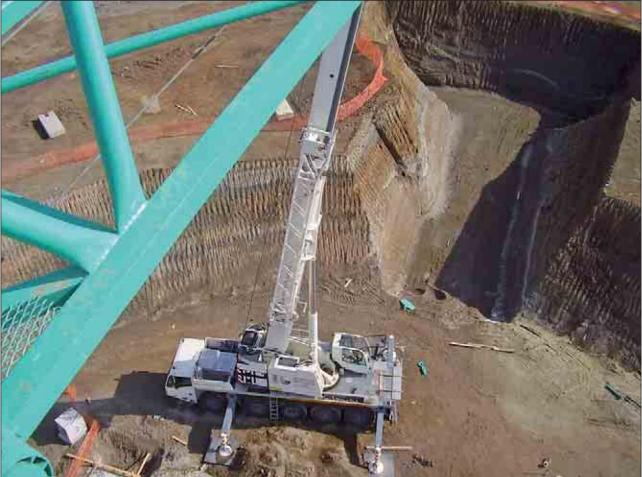
Sviluppo in quota del braccio dell'autogru a servizio del montaggio della gru a torre
