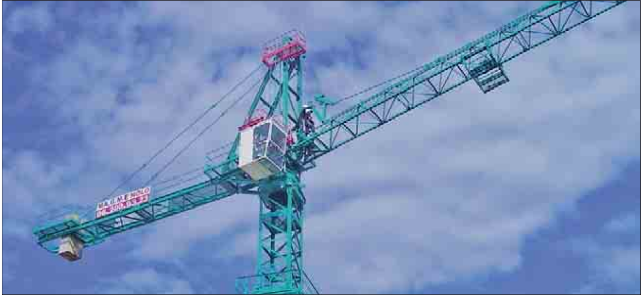
Sollevamento dei tiranti del braccio
