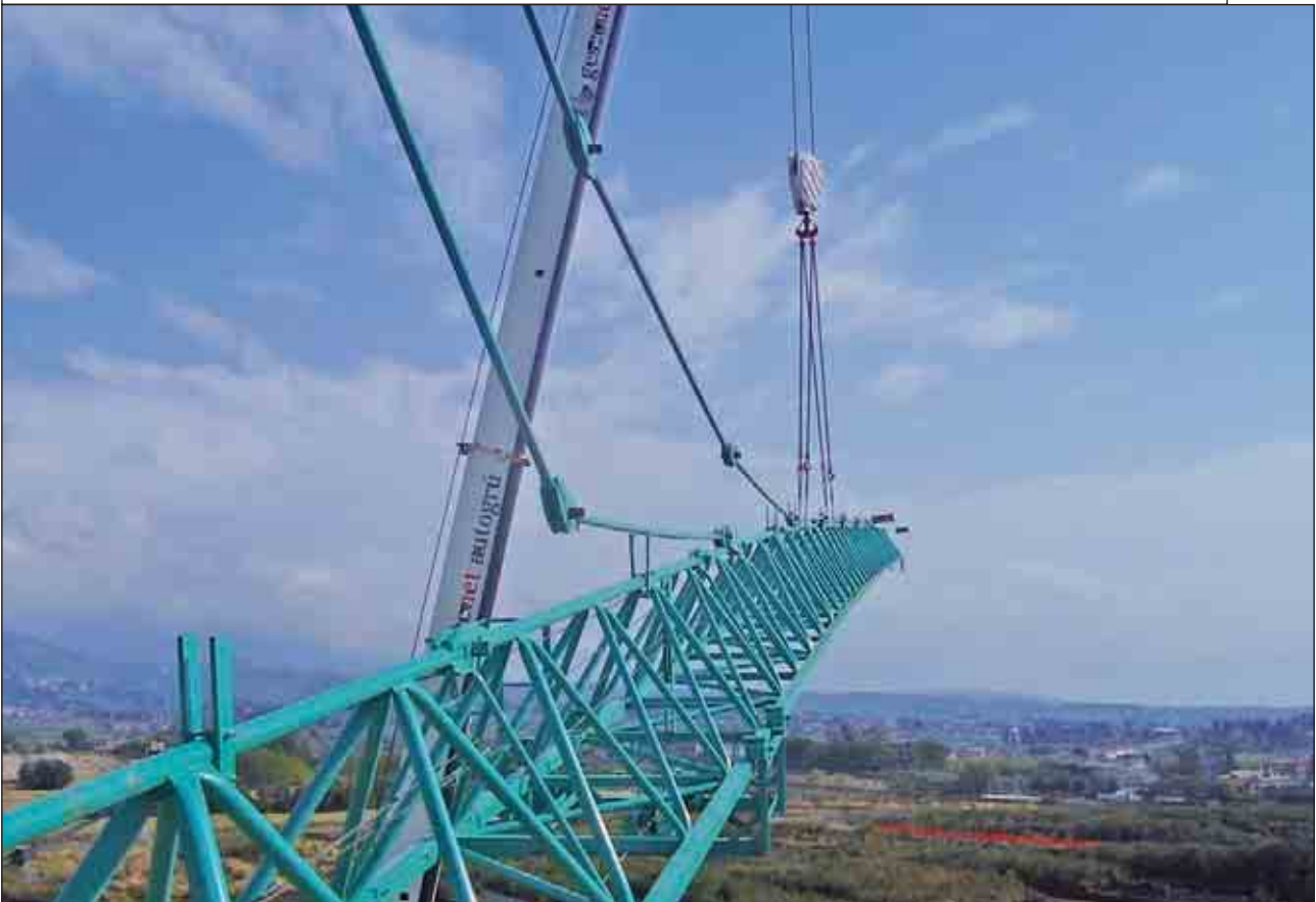
Il braccio, ormai montato, è ancora sostenuto dall'autogrù. Il sistema di aggancio è visibile sullo sfondo
