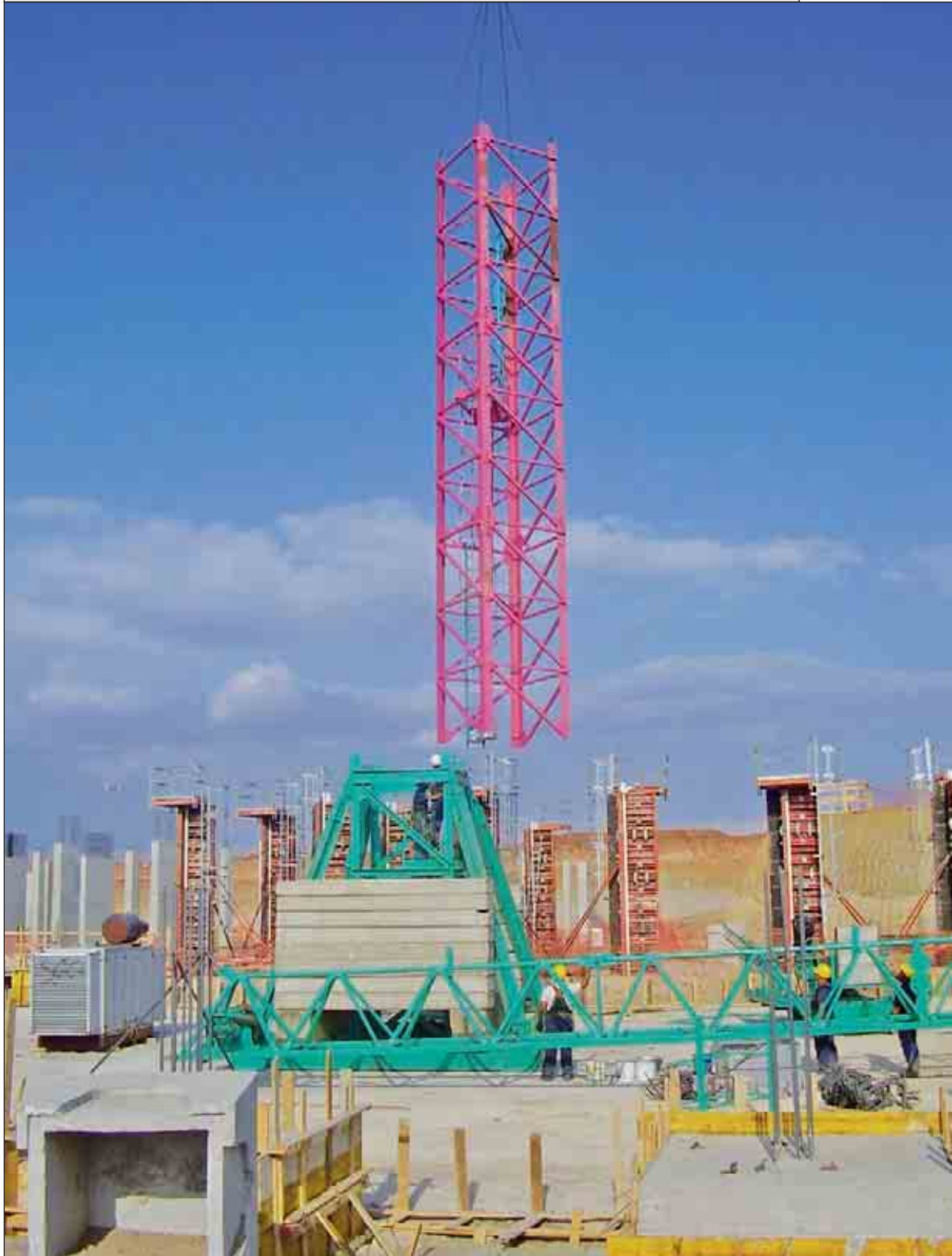
Sollevamento e trasporto in quota dell'elemento in prossimità di quello già montato
