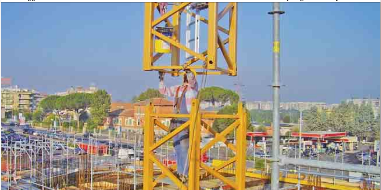
Montaggio di un elemento di torre: 2 - Montatore che afferra la base dell'elemento per gli ultimi spostamenti
