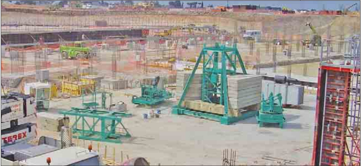
Da sinistra a destra: Parte del controbraccio, carro di base completo di zavorra, elemento ralla
