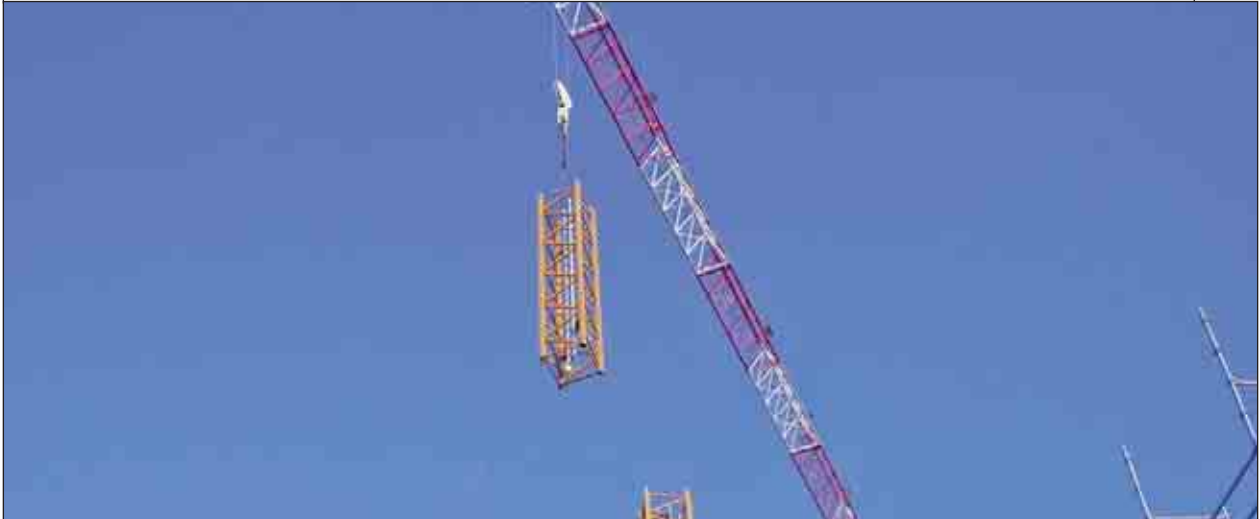
Montaggio di un elemento di torre: 1 - Operaio all'interno della torre in attesa dell'elemento guidato con fune
