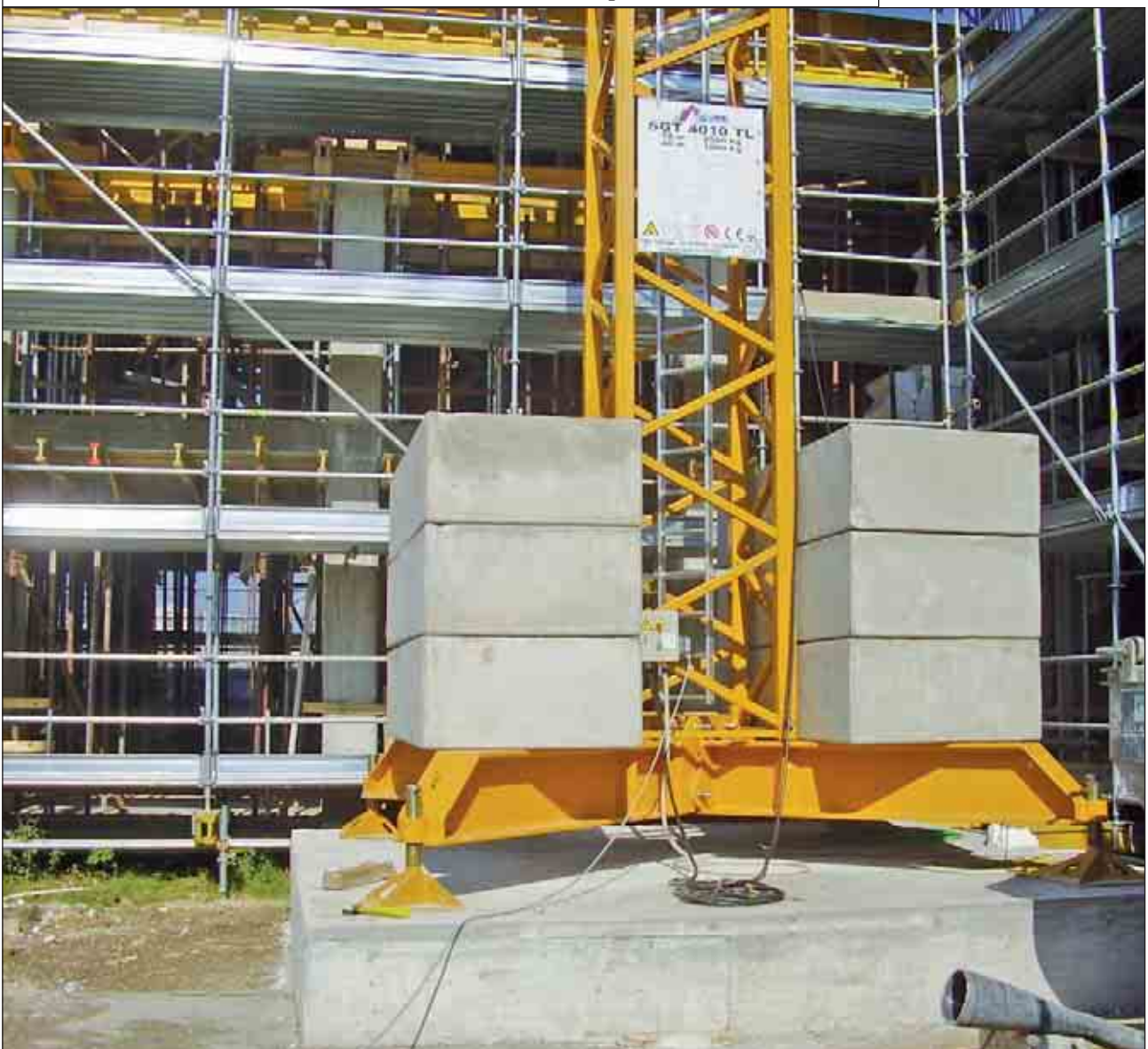
Piattaforma di base, zavorra e tabella con marchio CE sul primo elemento di torre
