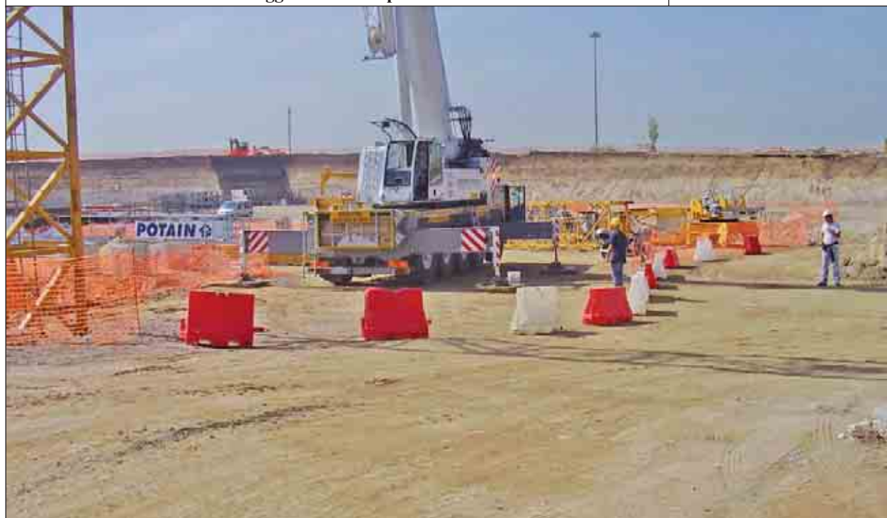
Delimitazione dell'area di montaggio con rete di plastica e barriere ad alta visibilità
