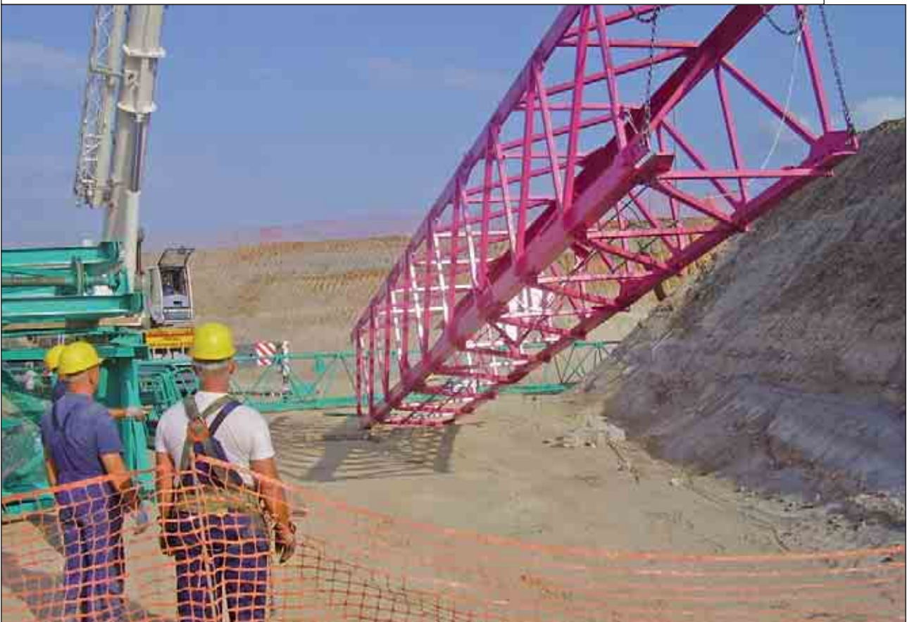
Prima fase di sollevamento: 1 - Passaggio dalla posizione orizzontale a quella verticale di montaggio
