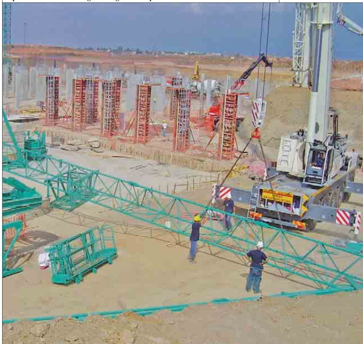
Operatore a terra che segnala al gruista di procedere al sollevamento del braccio
