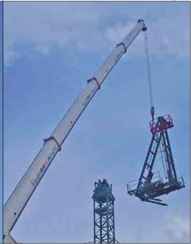
Arrivo della cuspid e con parte del controbraccio
