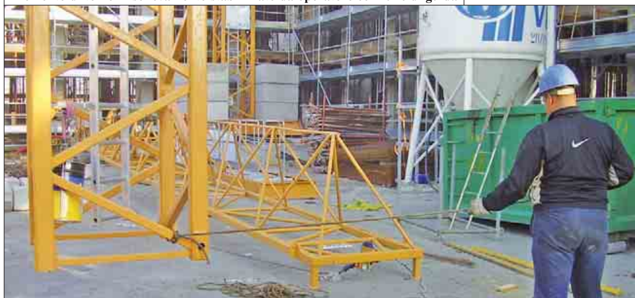
Elemento di torre in sollevamento stabilizzato da operatore con fune di guida
