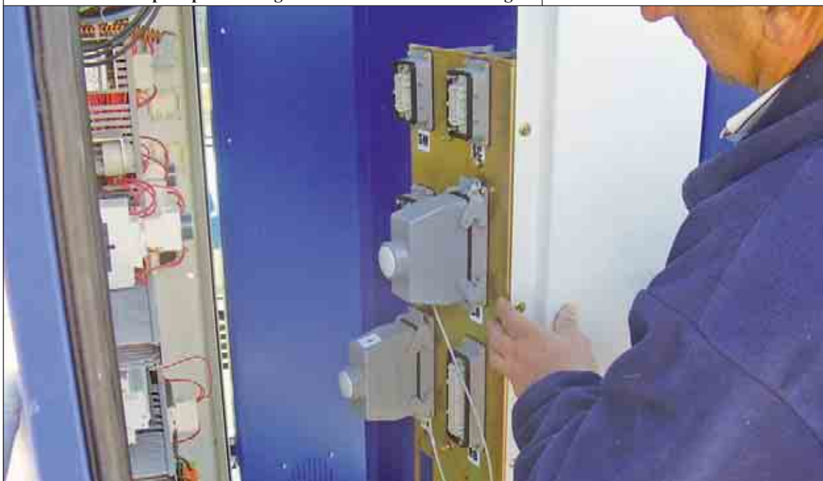
Prese a innesto rapido per il collegamento dei movimenti della gru
