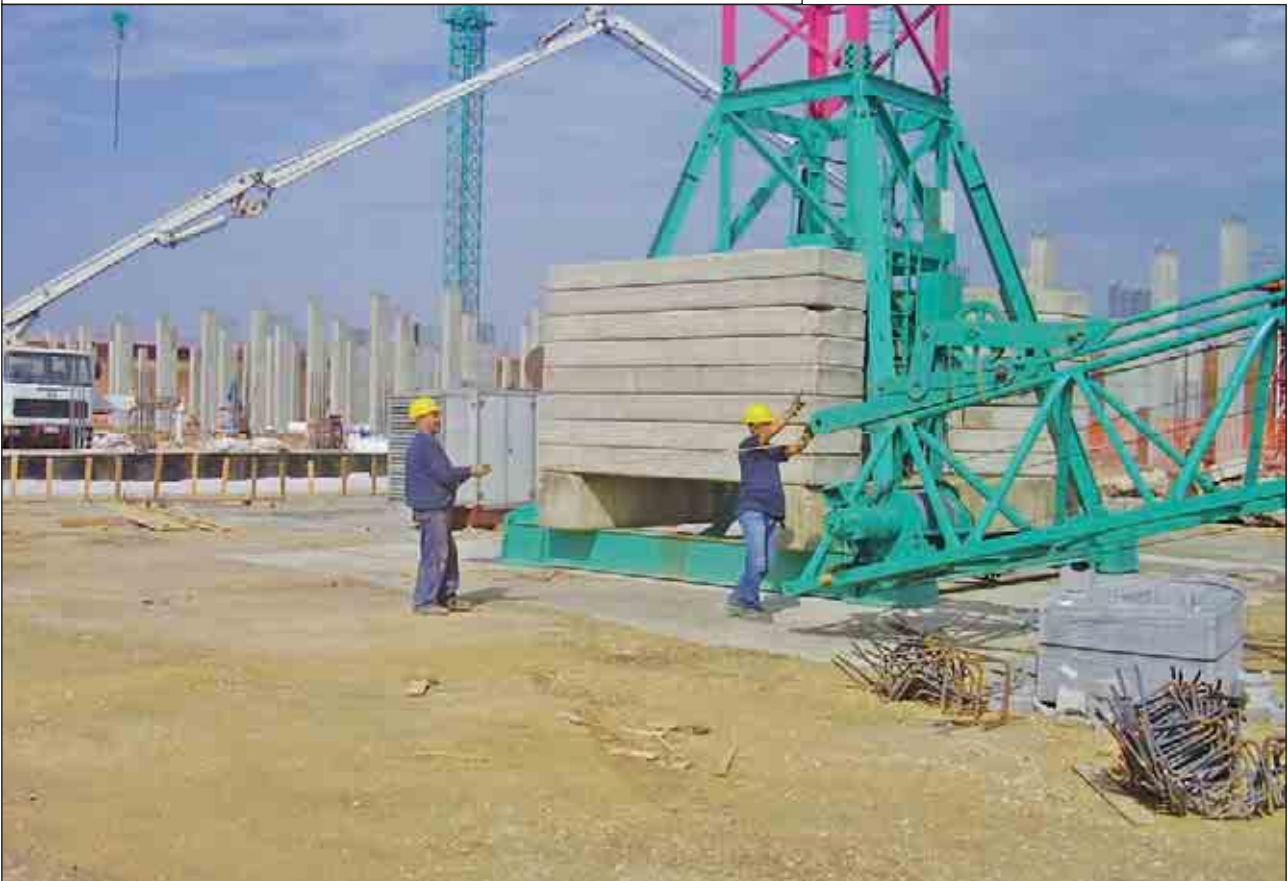
Prima fase del sollevamento da terra del braccio con fune di guida
