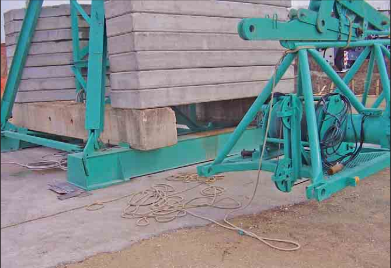
Fune di guida preparata a terra prima del sollevamento del braccio
